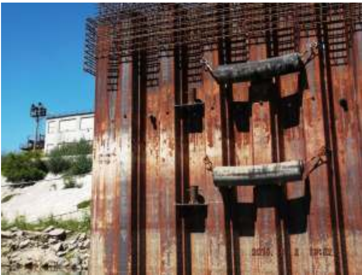
Armare grindă de coronament și amortizori cheu
